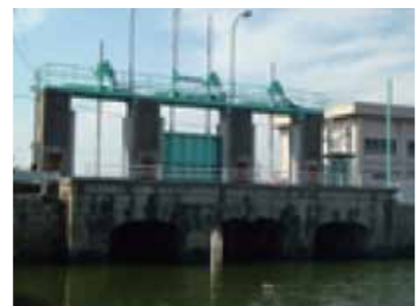
⑩ 丙川三連樋門
