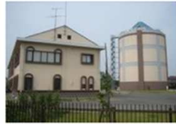
農業用排水機場
