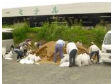
土の配布(台風時)
