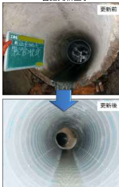
管路更新工事
