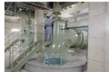
浦安ポンプ場 ポンプ能力の増強 (H27.3月完成) 436m 3 /min ⇒ 792m 3 /min
