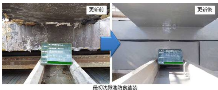
岡東浄化センター改築更新工事
