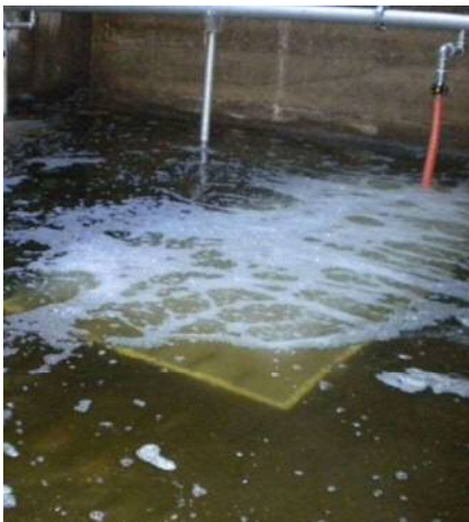
岡東処理場の散気装置
