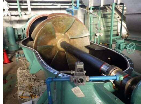
雨水ポンプ分解状況
