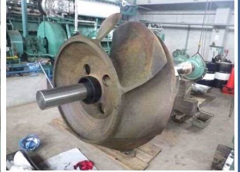
雨水ポンプ羽根車の整備
