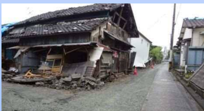
【熊本市内の被害状況①】
