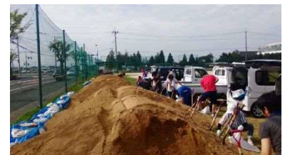
土のう配布の様子
