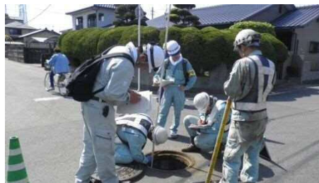
マンホール調査
