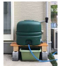
雨水タンク設置事例
