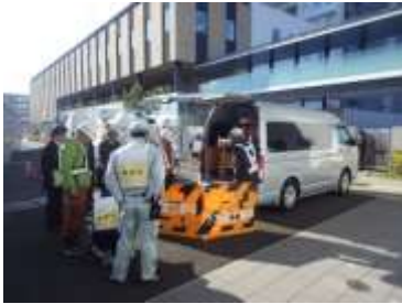
下水管TVカメラ調査（市民病院）
