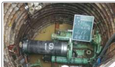
接続幹線 施工状況 (芳賀佐山)
