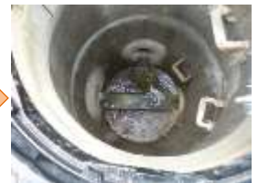
地下水流入箇所止水
