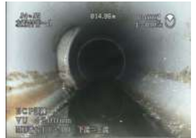
TVカメラによる下水管内部
