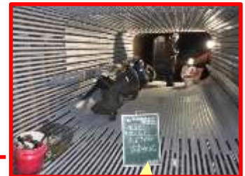
更生工により耐震性を確保
