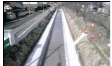
浦安12号雨水幹線 完成
