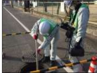
管口カメラによる下水道管調査
