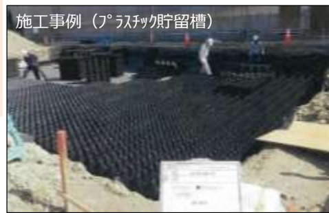
雨水流出抑制施設
