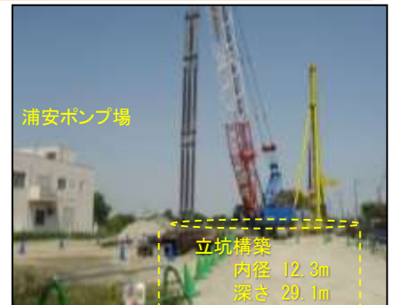
発進立坑構築（浦安11号雨水幹線）
