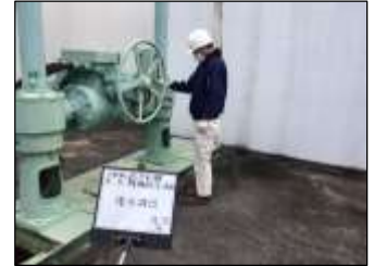
下水道施設の点検調査
