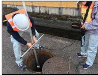
管口カメラによる下水道管調査
