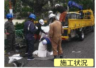
鹿田町一丁目地内管更生工事
