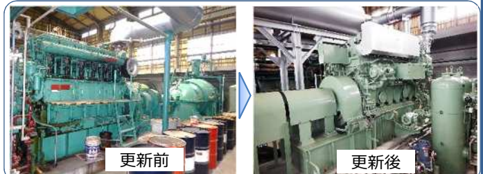
天瀬P場雨水ポンプエンジン更新
