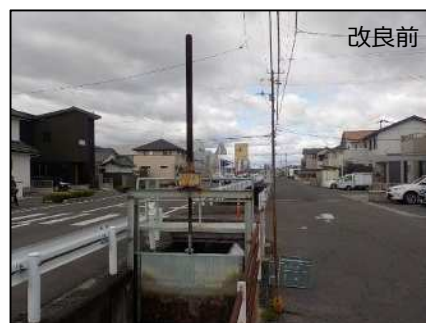
樋門改良工事
