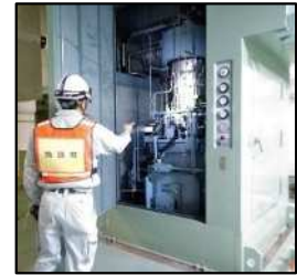
下水道施設の点検調査
