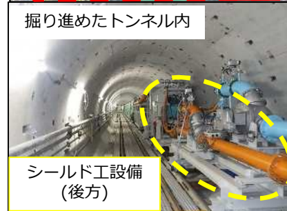
掘進着手（浦安11号雨水幹線）
