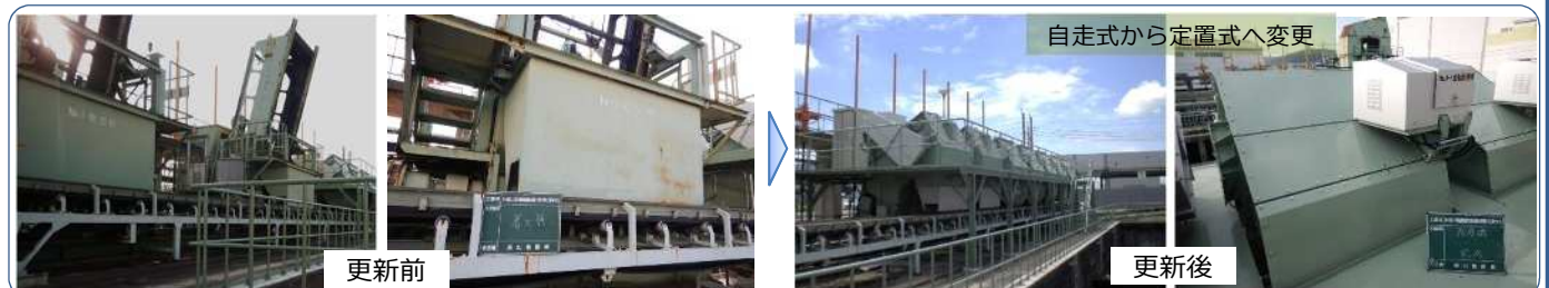
笹ヶ瀬P場自動除塵機更新
