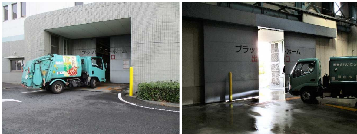
図 6-4 自動扉やエアーカーテンの設置例
