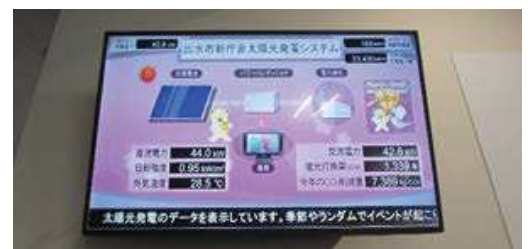
環境モニター（出水市庁舎）
