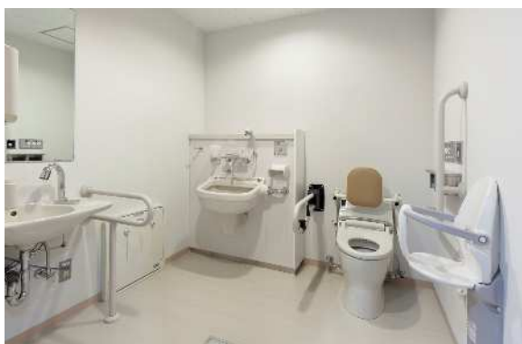
多目的トイレの事例（立川市庁舎）
