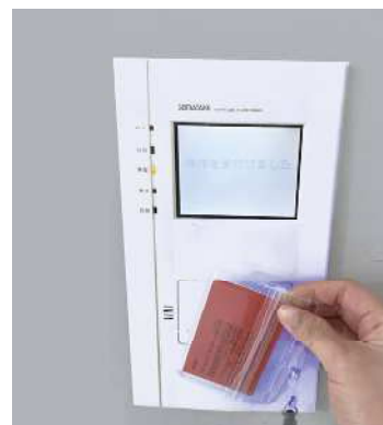
ICカードによる入室の事例
