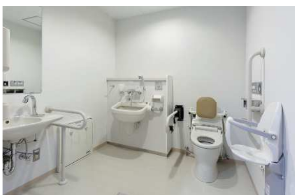
多目的トイレの事例（立川市庁舎）
