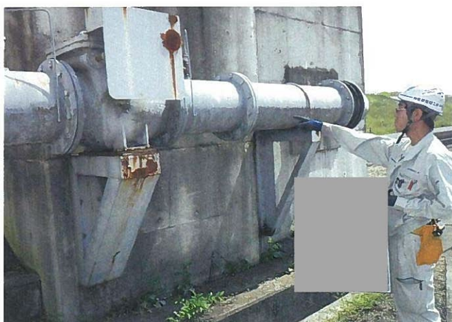
点検状況写真
