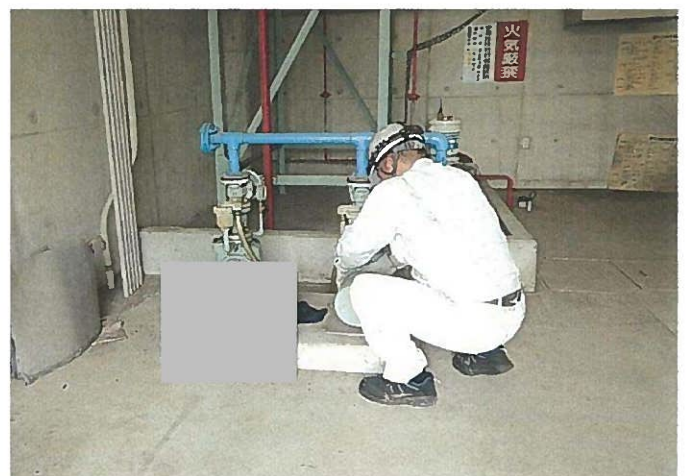
点検状況写真
