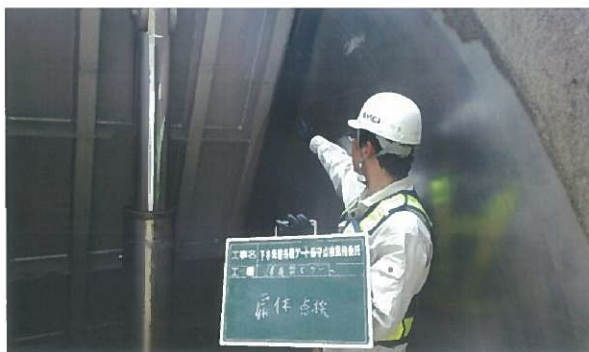
保守点検実施状況 (津島第5ゲート)
