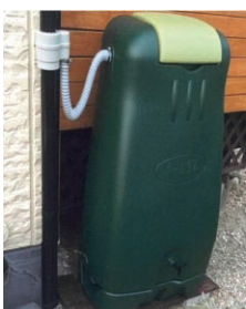
▲雨水貯留タンク設置例
