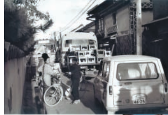
▲昭和41年頃の県道倉敷妹尾線の様子
