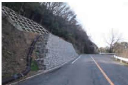
▲復旧工事後の様子
