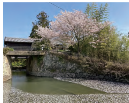
▲倉安川吉井水門
