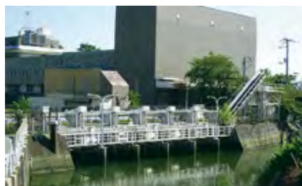
▲秋芳川排水機場の一部 (ポンプ施設は地下)
