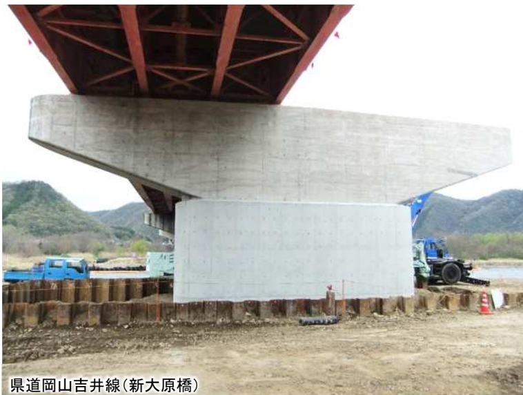
橋脚の補強による耐震化
