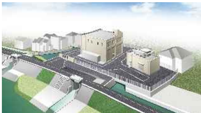
今保ポンプ場建設イメージ
