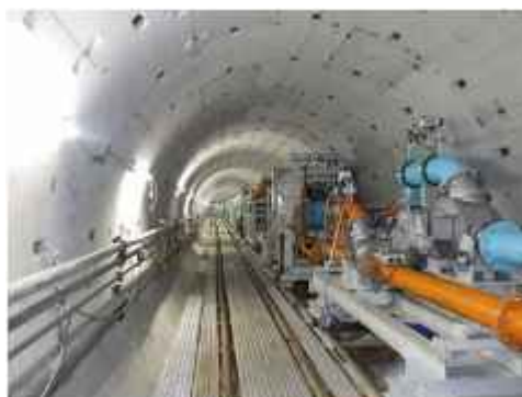
浦安11号幹線雨水管 施工状況(令和4年1月)
