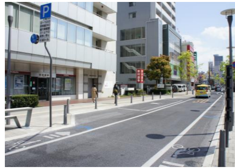
▲荷捌き用駐車スペース (岡山市：県庁通り)
