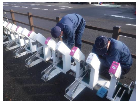
▲ももちやり機器の修繕状況 (岡山市)
