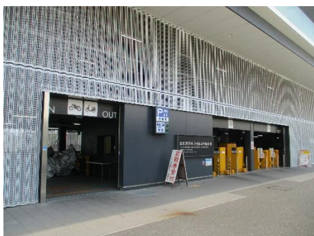
(岡山市：北長瀬駅南口自転車等駐車場)
