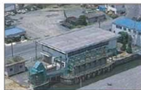
岡南ポンプ場(現状)
