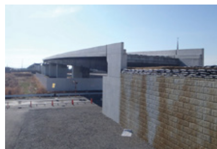
▲JR瀬戸大橋線跨線橋付近
