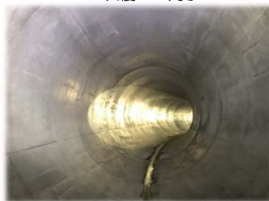
二次覆工 完了
