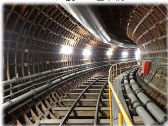
二次覆工 着手前
