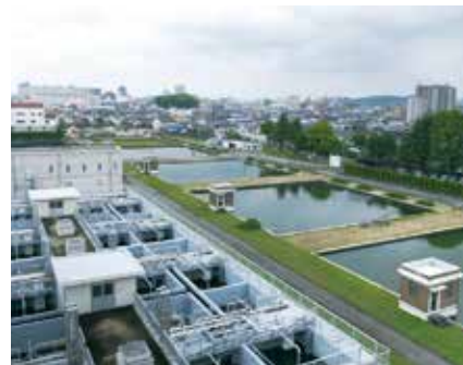
更新工事を進めている三野浄水場
