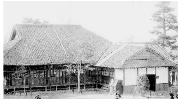
池田光政閑居の間(西の丸御殿の一部)
