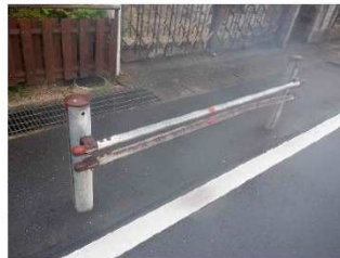
ガードレールの損傷
