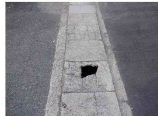
側溝の破損
