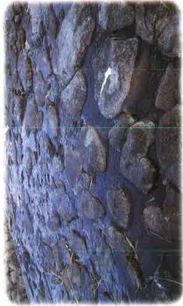
流れに逆らわず、玉石により巻石施工されている
