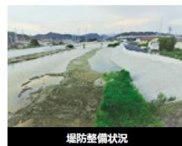
堤防整備状況
