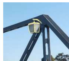
塗り替え後の照明 (イメージ)
