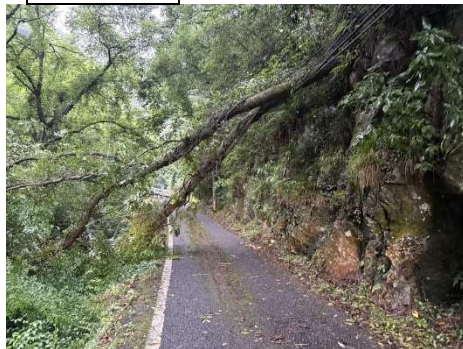
現地状況写真
