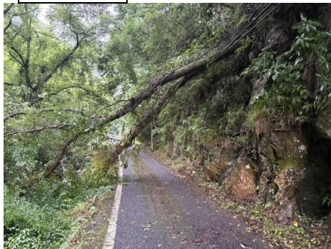
現地状況写真
